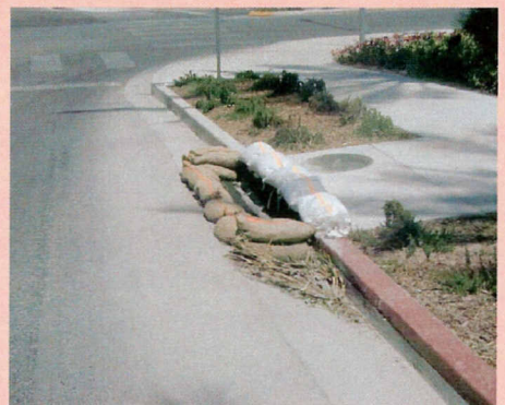
Do Not Block Inlets in Public Streets Except When Cleaning Paved Streets No Bloquee las Entradas en Calles Publicas Menos Cuando Limpiando Calles Pavimentecas
