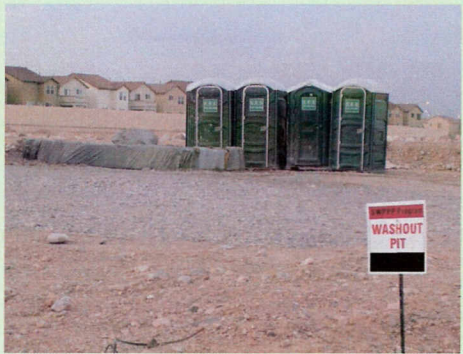
Washout Pit Hoyo de Lavadó
