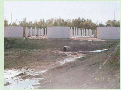
Retention Pond Estanque de Retención
